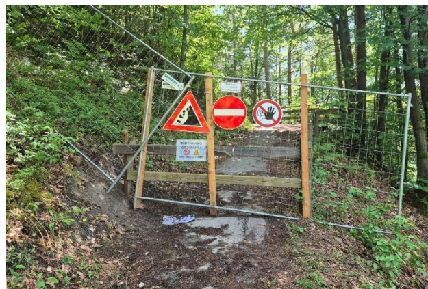
Bild 2: Absperrung R1 Wudmath Seite Wernberg
